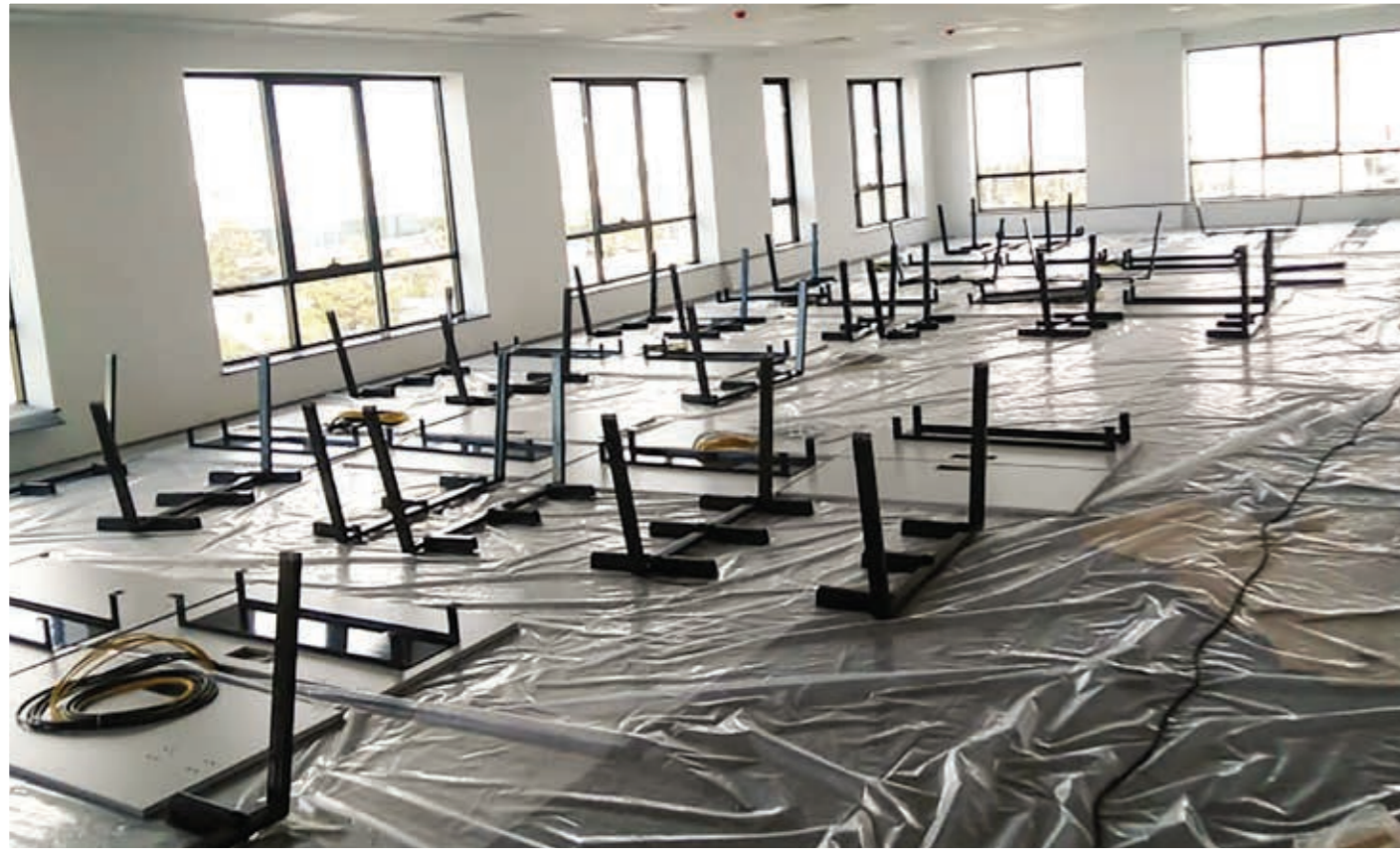
Installation des bureaux Bench Isocèle dans l'open-space
